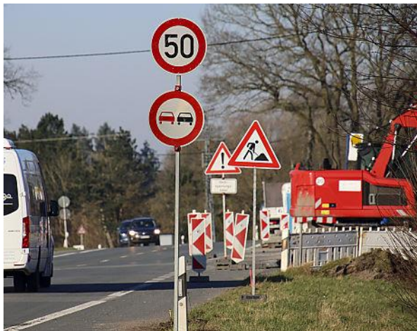
Abbildung 1 (links): Baustelle (Quelle: Kreis Coesfeld)
