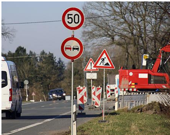
Abbildung 1 (links): Baustelle (Quelle: Kreis Coesfeld)
