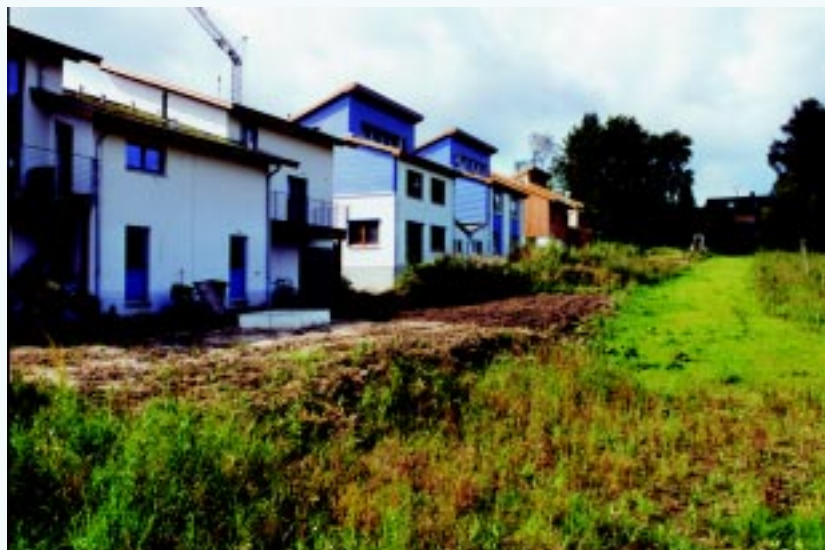
Siedlung „Am Elsebad“ in Schwerte-Ergste, ein Beitrag Schwertes zum Modellvorhaben „Zukunftsweisender Wohnungsbau um Kreis Unna“, hier noch in der Bauphase.
