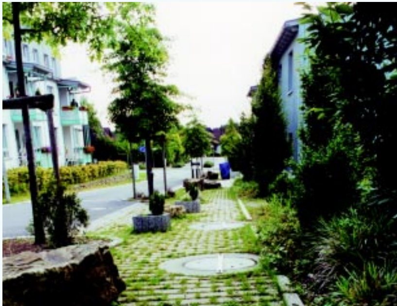
Schwerte: Am Zimmermanns Wäldchen; im Bildvordergrund die Deckel von Regenwasserzisternen
