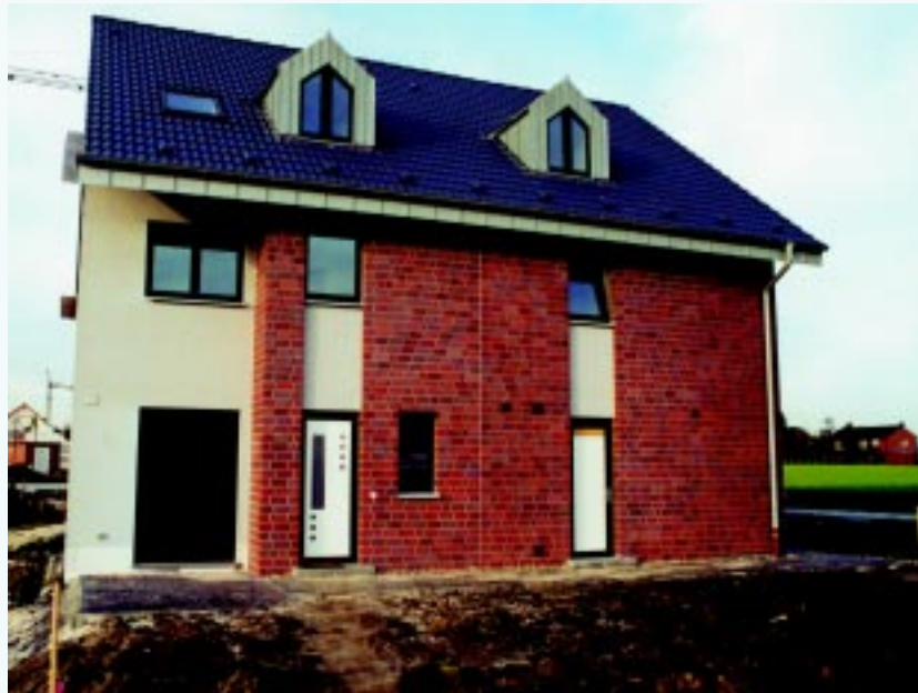
In Werne, Am Fürstenhof, entsteht z.Z.Deutschlands größte erdwärmebeheizte Wohnanlage
