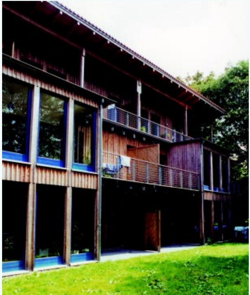
Ein Beispiel für ökologischen, kostengünstigen Wohnungsbau, Dahlienstr. 4 in Unna-Königsborn. Durch nach Süden ausgerichtete Wintergärten wird die Sonnenenergie passiv genutzt.
