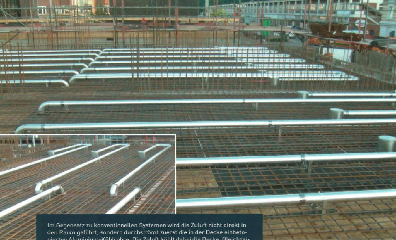
Im Gegensatz zu konventionellen Systemen wird die Zuluft nicht direkt in den Raum geführt, sondern durchströmt zuerst die in der Decke einbetonierten Aluminium-Kühlrohre. Die Zuluft kühlt dabei die Decke. Gleichzeitig werden die Wärmegewinne zum Nachwärmen der Zuluft genutzt.
