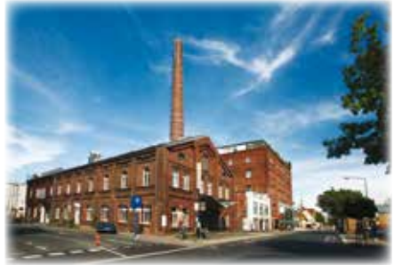
Dienstgebäude | Massener Straße 35
