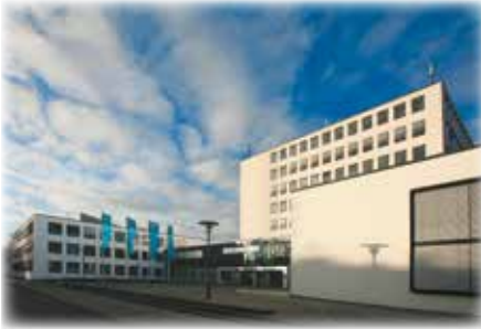
Kreishaus Unna | Friedrich-Ebert-Straße 17
